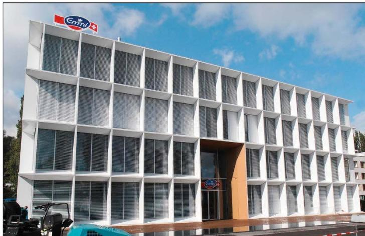
Die weiss pulverbeschichteten, vorgebauten, charakteristisch dominant wirkenden Kastenelemente sind mit Alucore Verbundplatten - ein Produkt der Allega AG - gebaut. Diese sehr leichte Platte besteht aus zwei Aluminium-Deckblechen und einem Wabenkern, welcher ebenfalls aus Aluminium gefertigt ist.
