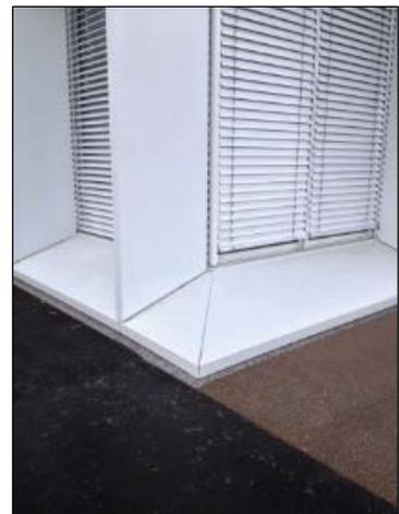
Im Erdgeschoss sowie im 1. Obergeschoss kam zusätzlich zu der weissen Pulverbeschichtung ein hochwertiger 2-Komponenten-Graffitienschutz auf Fluorpolymerbasis zur Anwendung.
