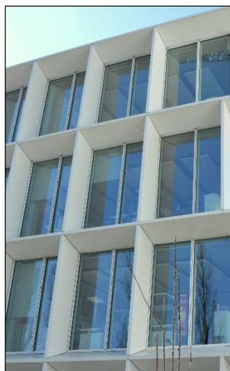
Bautiefe von 900 Millimeter. Der Verlauf erstreckt sich ununterbrochen rund um das ganze Gebäude. Integriert in die horizontalen Elemente sind die Pakete der Rafflamellen-Storen.
